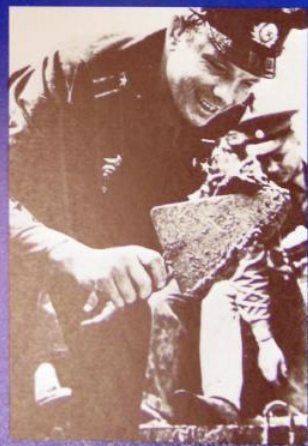
Закладка первого камня будущего
