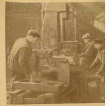
Установка оборудования в мехцехе восстанавливаемого И-ского
