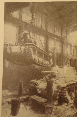
В восстановленном цехе И-ского завода идет ремонт танков.
