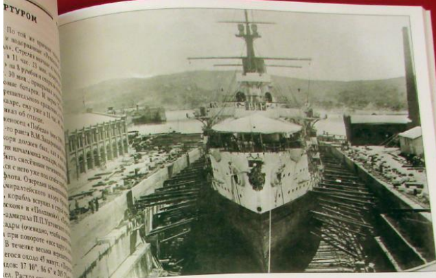
«Пересвет» прибыл в Порт-Артур 5 апреля 1902 г. В августе того же года он прошёл докование во Владивостоке (верхнее фото), в ходе которого высилось ослабление крепления форштевня к килю, что потребовало экстренных работ по подкреплению. «Победа» пришла в Восток значительно позднее собрата — в июне 1903 г. На фото внизу «Победа» и «Пересвет» (слева вдали) на внешнем рейде в начале кампании 1904 г.
