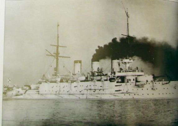
«Победа» на Балтике летом 1902 г. перед уходом на Дальний Восток. Хорошо видны внешние отличия броненосца от собратьев — протяжённый, далеко выдвинувшийся вперёд форштевень, гот-мачта шестового типа, прожекторный мостик к носу от второй трубы. Все четыре «противобордажные» 47-мм скорострелки корабля сосредоточены на форм-море. Обе стёнки развёрнуты в нос.
